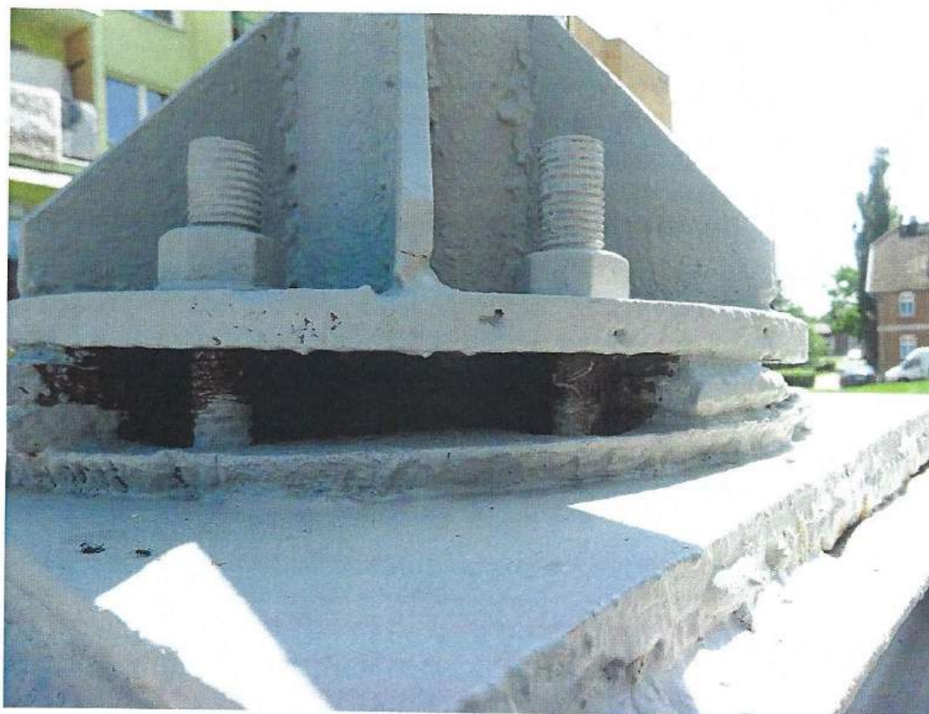
Wieża kratowa – mocowanie do fundamentu
