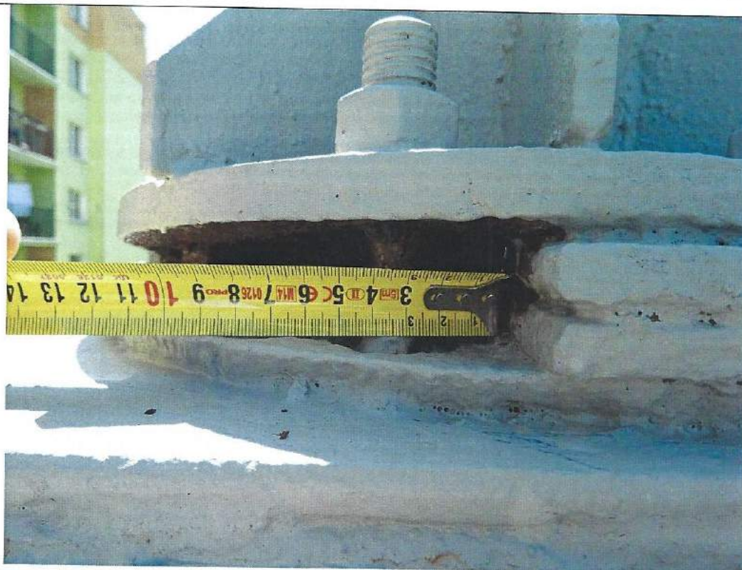
Wieża kratowa – mocowanie do fundamentu
